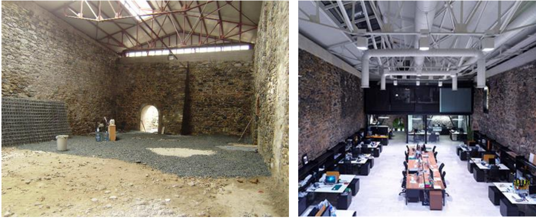
Görsel 1. Kasımpaşa Tuz Ambarı yeniden kullanım öncesi (solda) ve sonrası (sağda), (Turgul, 2015).
