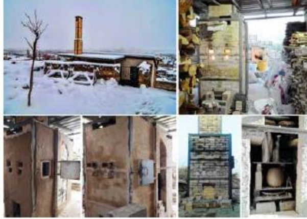
Görsel 2.12. Dumanlız Anagama Fırını, Avanos, Nevşehir (Shigeru Hirata kişisel fotoğraf arşivi)
