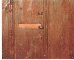
Resim: 37a Kapının Arka Tarafından Aynı Kilidin Açma Dili.
