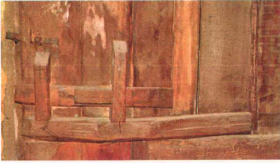
Resim:37 Avanos Yöresi'ne Ait ve Halen Kullanılmakta Olan TOKMAK Konuk Evi'nin Ahşap Kapı Kilidi.
