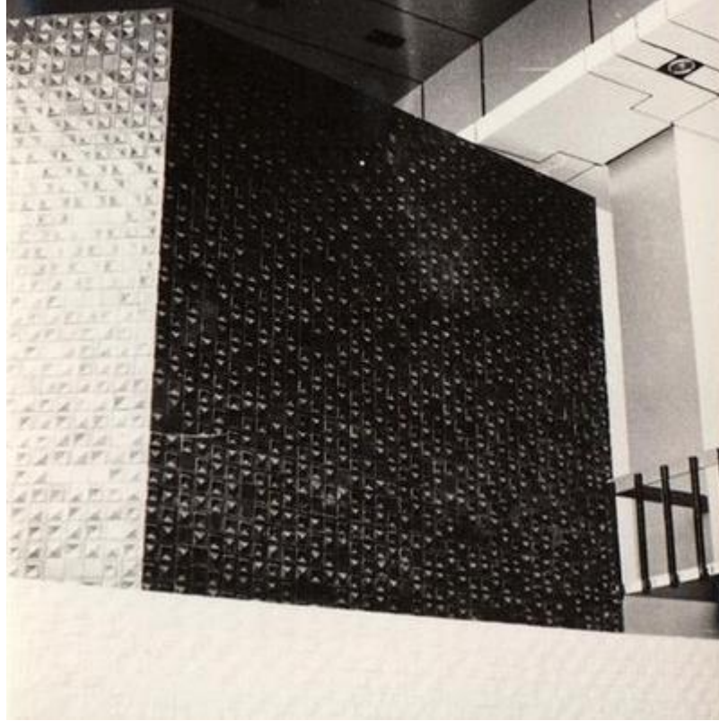
Resim 103. Atatürk Kültür Merkezi iç mekân seramik duvar pano uygulaması.
